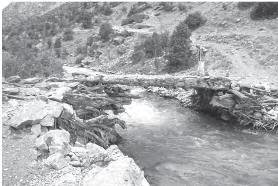
Рис. 5. Мост через Оби-борик. Фото автора. 2008 г.
