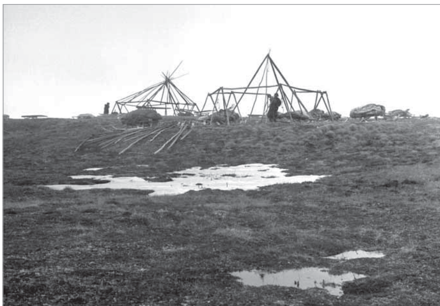
Рис. 93. На переднем плане чукчанка Кынэп устанавливает ярангу. На заднем плане — готовый остов яранги Майныкааквургына, еще не покрытый ровдугой. Ыпъэн, весна 1951 г. МАЭ РАН. И 1454-33
