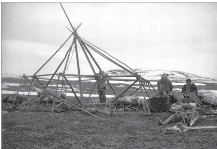
Рис. 87. Установка яранги на новом месте. Подросток Чымнугэ привязывает верхние жерди (утэм), его родители Гырголькай и Ринтынэ приподнимают тяжелое покрытие яранги (рэтэм). МАЭ РАН. И 1454-78
