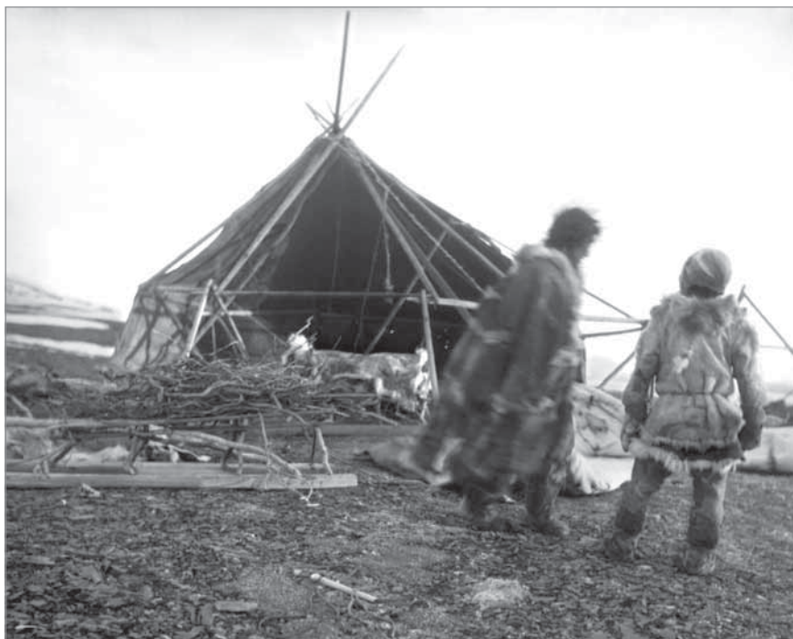
Рис. 89. Недостроенная яранга с натянутой половиной покрытия (рэтэм).
