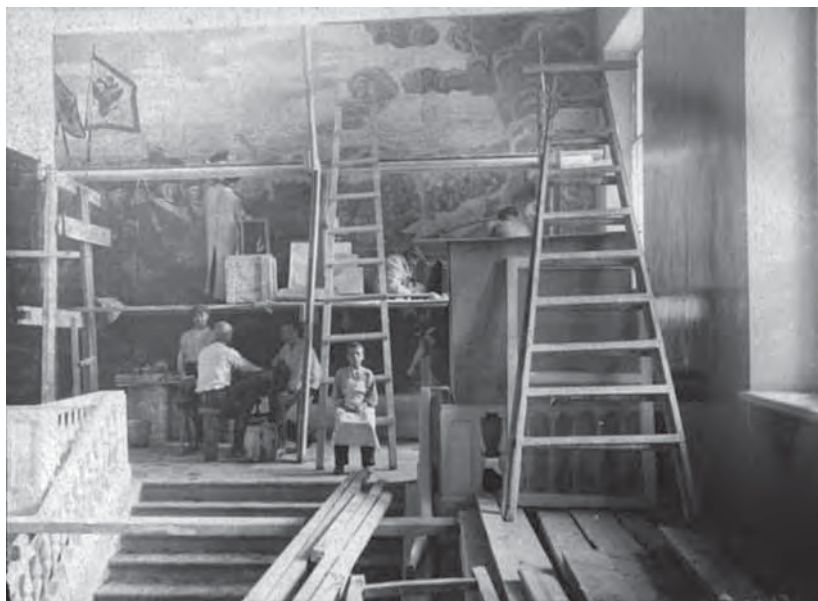
Рис. 3. Заделка швов мозаики. Фотография 1933 г.
