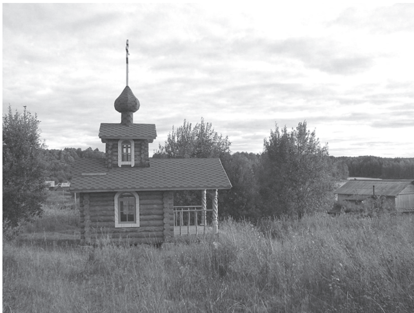
Рис. 3. Часовня в д. Юбеничи Подпорожского р-на Ленинградской обл. Фото И.Ю. Винокуровой, 2010 г.
