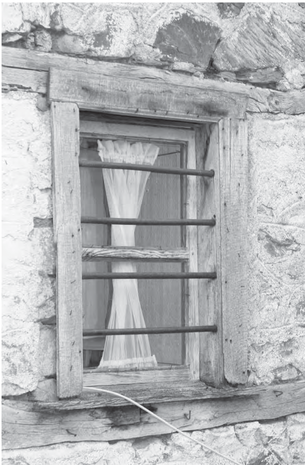
Рис. 4. Окно жилого двухэтажного дома. Дом принадлежит Реджепу Садиковскому (алб. Rexhep Sadikovski). Рама окна деревянная. Железные решетки в виде горизонтальных прутьев. Дом сложен из природного камня — характерная черта местной строительной традиции. С. Требишт. Фото А.А. Новика. 2009 г. Колл. МАЭ № ВХ ЭФЗК 167-188
