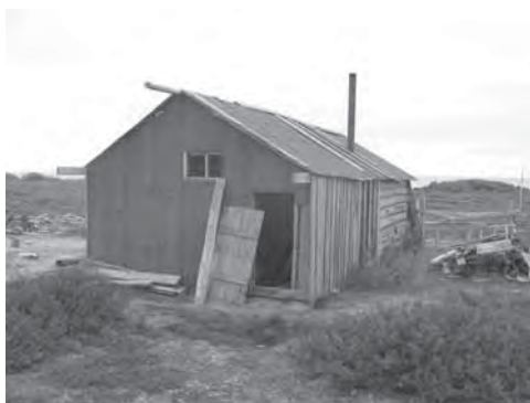
Рис. 3. Задняя часть избушки. Сарай, пристроенный к избушке
