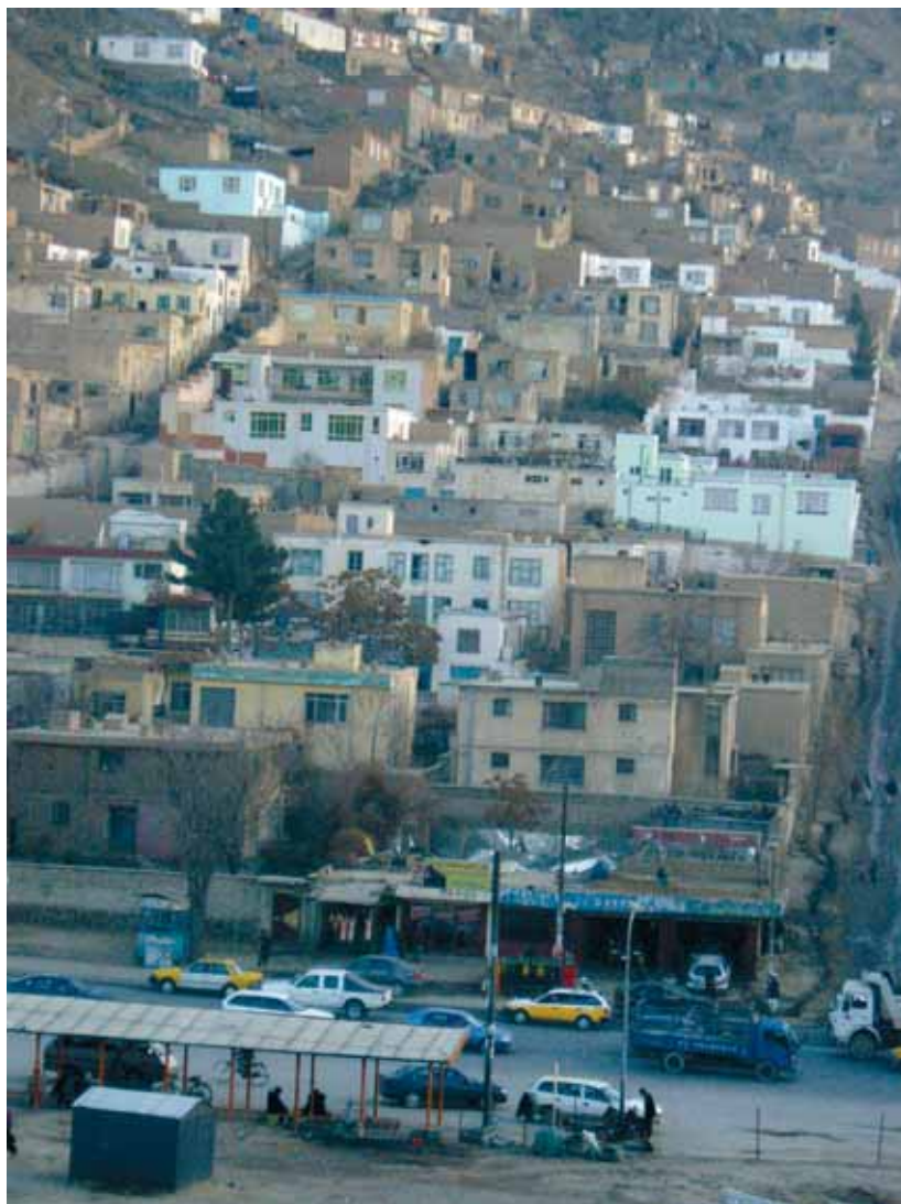
№ 5. Город Кабул. Квартал жилой застройки, расположенной на склоне горы в центре города. Постройки расположены ярусами. На переднем плане идущая вдоль склона большая оживленная улица, расположенные на ней навесы для ожидающих транспорта и торговые ларьки
