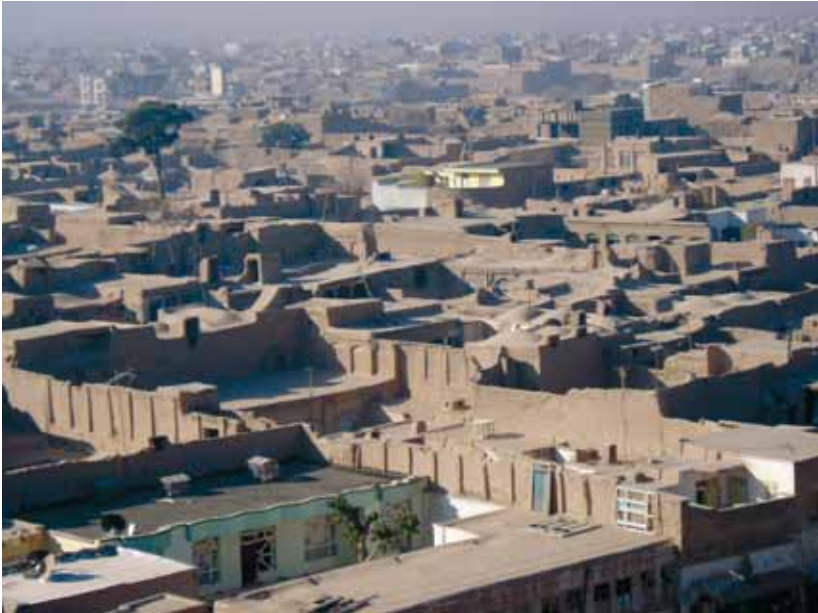
№ 99. Герат. Вид на один из кварталов старой части города со стен арка. Регулярная застройка квартала жилыми домами. На переднем плане один из жилых домов с оштукатуренными и покрашенными белой краской стенами
