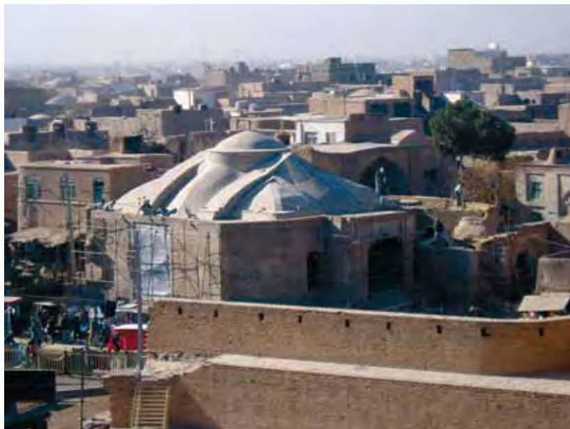
№ 103. Герат. Общественный резервуар для воды, построенный несколько сотен лет назад. Рабочие, производящие реставрационные работы на крыше сооружения
