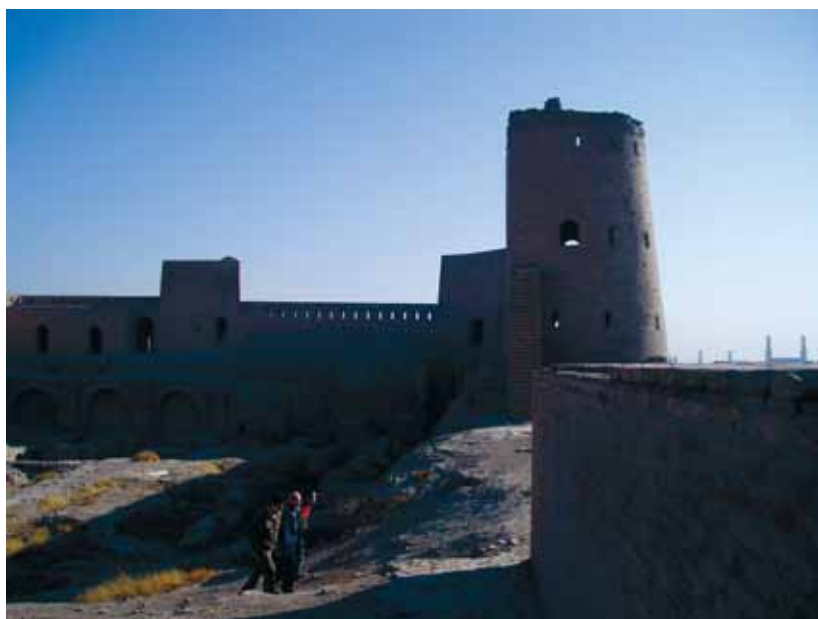
№ 95. Стены и башни центральной верхней части арка. В центре кадра трое мужчин, направляющихся к стене крепости
