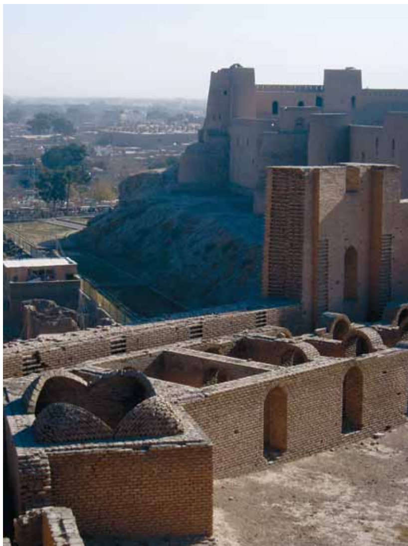
№ 102. Герат. Оборонительные сооружения арка. На дальнем плане главные стены и башни арка
