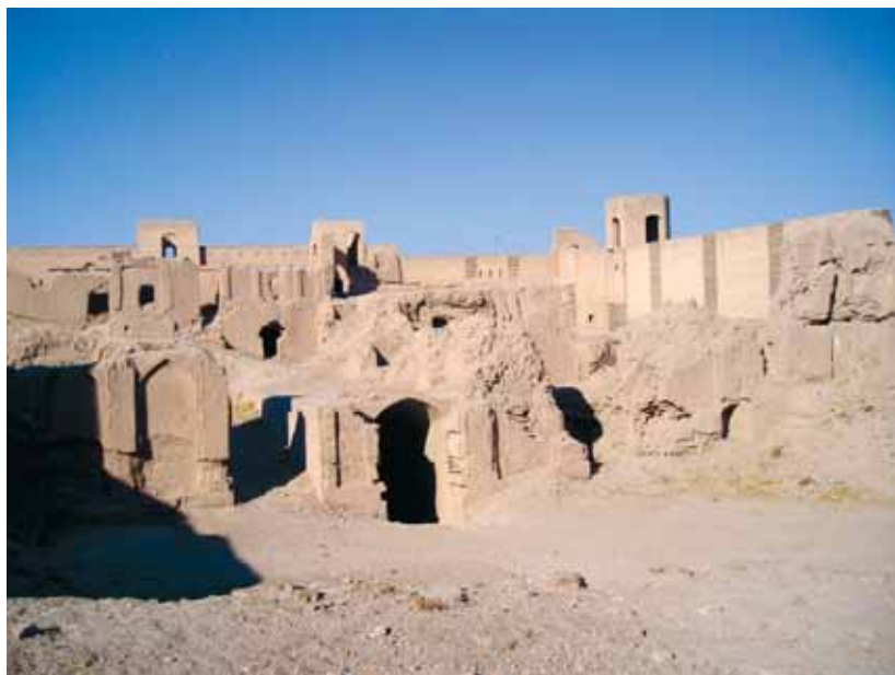
№ 94. Развалины построек, расположенных в верхней части арка. За постройками — крепостные стены, отреставрированные двадцать лет назад
