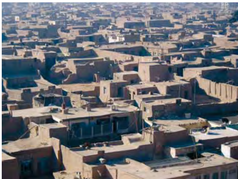
№ 98. Герат. Вид на один из кварталов старой части города со стен арка. Регулярная застройка квартала жилыми домами. Дома из сырцового кирпича
